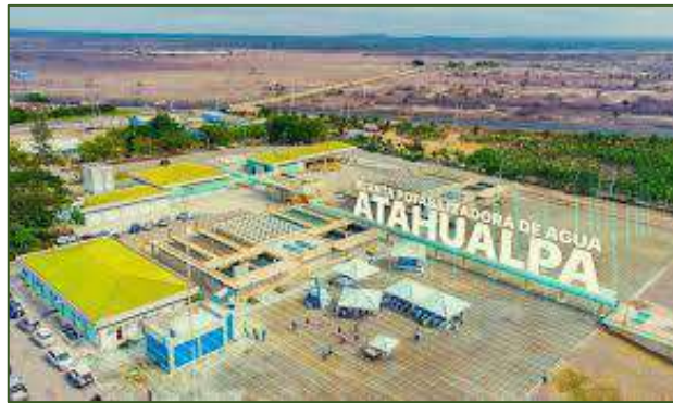
Foto 12: Planta Potabilizadora de agua
